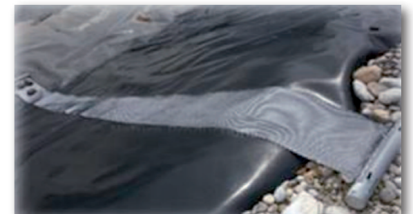
Rampe souple en géogrille.
