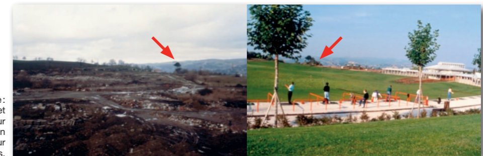
Golf de Saint-Etienne : le site avant et après travaux (pour se repérer : le pin solitaire présent sur les deux photos.
