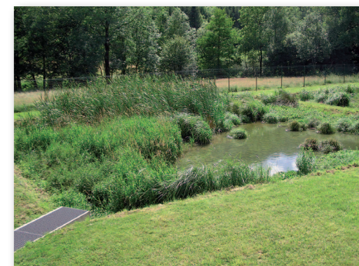
Exemple d'une zone de rejet végétalisée.
